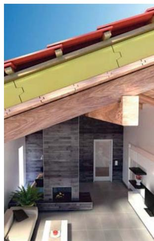
Wärmebrücken vermeiden kann man ideal mit einer vollflächigen Aufsparrendämmung oberhalb der Sparren. Foto: djd/puren
