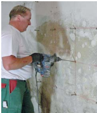
Vorbereitung zum Injizieren der Silikonharzlösung. Foto: veinal.de/akz-o
