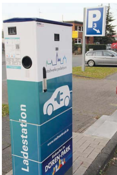
Ladesäule Senefelder Straße
