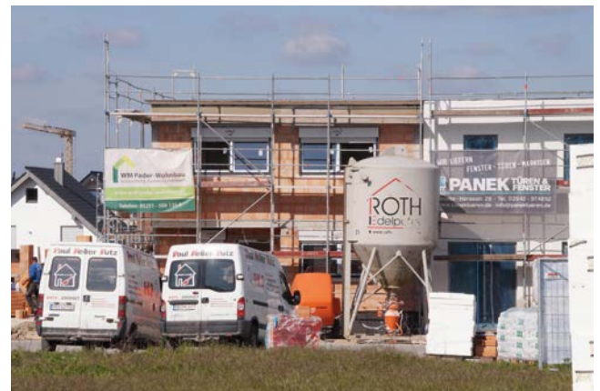
Auf den Baustellen herrscht überall geschäftiges Treiben. Zurzeit werden 17 weitere Grundstücke ausgeschrieben. Foto: Gruber
