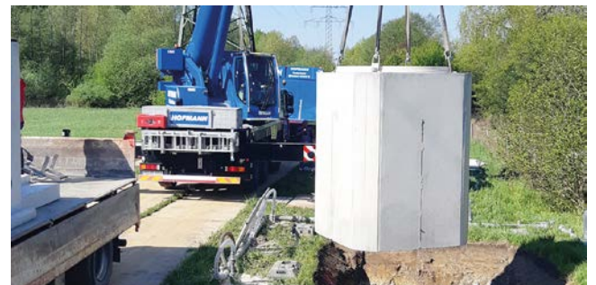
Für die Versorgung der Fischteiche wurde auf einer Länge von 500 Metern eine Wasserleitung verlegt. Dazu wurde ein unterirdisches Bohrverfahren (Horizontalbohrung) angewandt, so dass nur geringfügig Grabenarbeiten notwendig waren. Ende Juni wurden die Arbeiten fertiggestellt. Bildrechte: Stadt Paderborn
