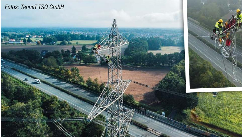
Flugwarnkugeln, die zur Sicherheit für den Luftverkehr an den Erdseilen befestigt sind, durch neue Kugeln ersetzt. Da die Leitung die A33 im Bereich des Altensener See direkt überspannt, fanden die
