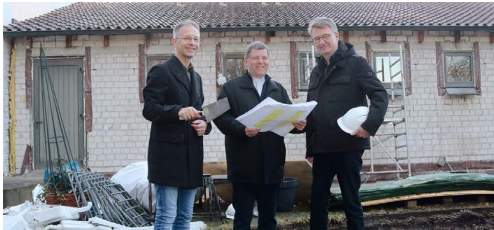
Bertold Filthaut, Bernd Haase und Hubert Wewer (v. l.) haben sich jetzt auf der Pfarrheim-Baustelle über den aktuellen Stand der Arbeiten informiert. Foto: Heiko Appelbaum
