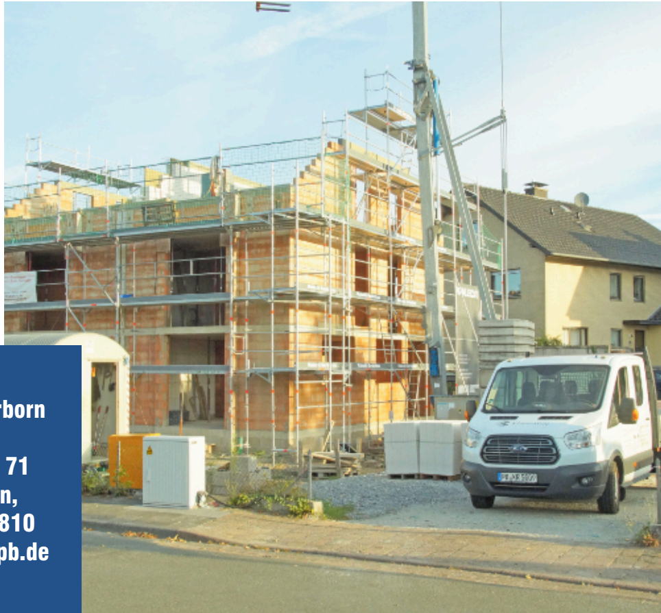
Baustelle am Kurwald, Foto: Herbert Gruber
