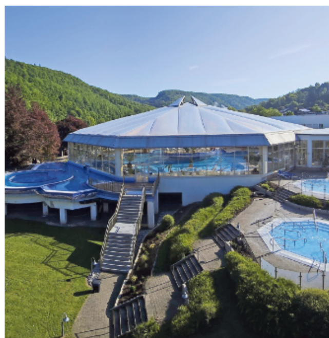
Weser-Therme mit neuer Lüftung und frischem Glanz. Foto: Weser-Therme Bad Karlshafen
