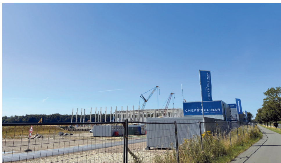
Der Neubau des CHEFS CULINAR-Zentrallagers auf dem Airport Campus nimmt immer mehr Gestalt an. Foto: Flughafen Paderborn/Lippstadt GmbH
