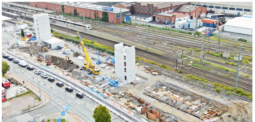
Ein Luftbild zeigt die beiden Treppenhäuser und den Baufortschritt des Parkhauses am Bahnhof. Bildrechte: Stadt Paderborn
