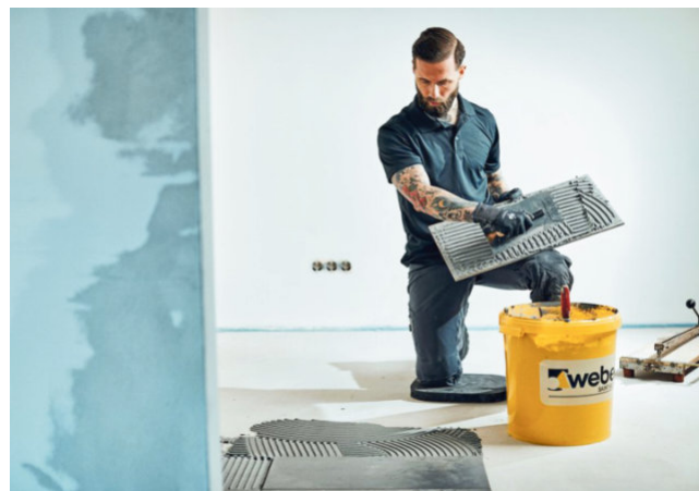
Profis aus dem Handwerk können zu den Möglichkeiten einer Badezimmer-Modernisierung mit neuen Fliesen beraten. Foto: djd/Saint-Gobain Weber/Chris Rausch
